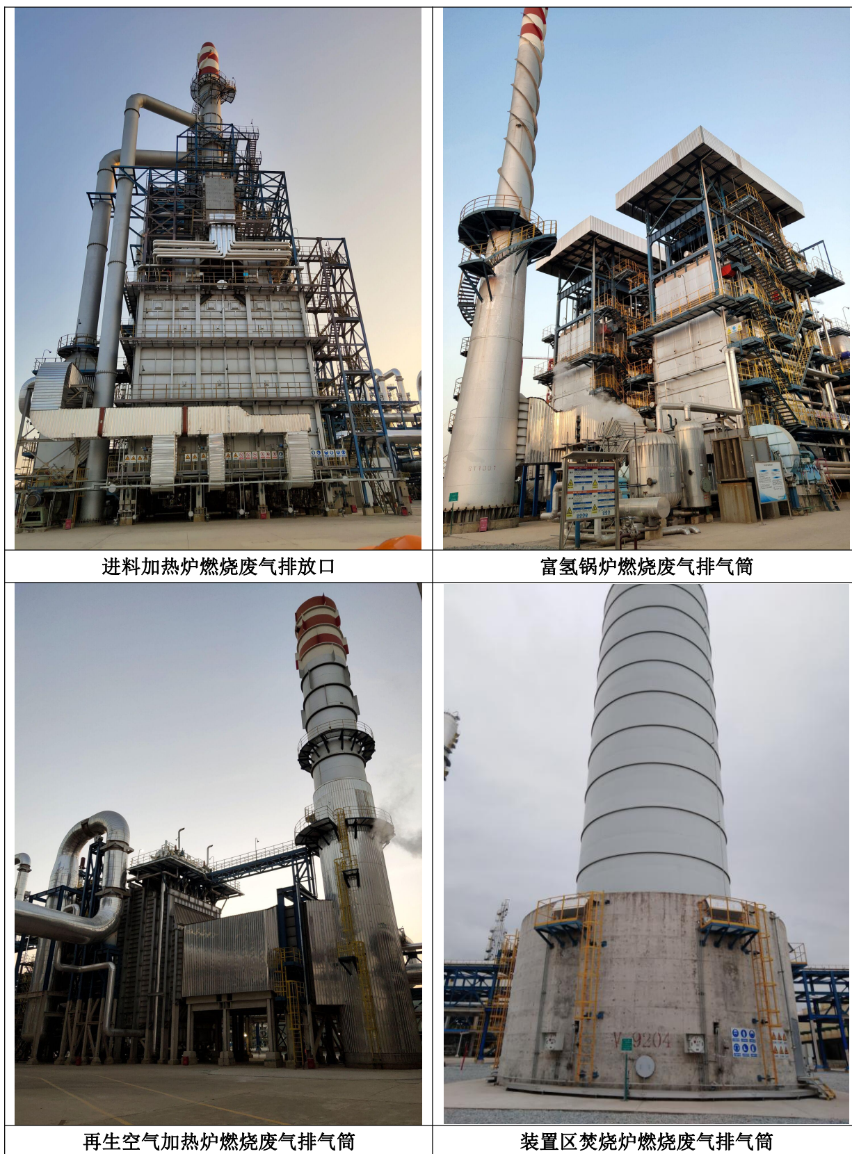
图 4.1-17 废气排气筒现场图
